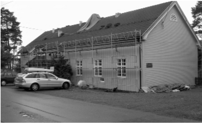
Nytt tak på Høybråten "Bedehus".
