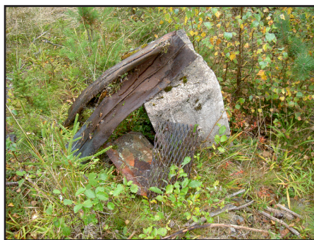
Hytta brant en gang etter krigen og dette er det eneste som står igjen, et fundament, et sotrør, en rist og en taksten
