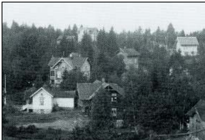
Olsetoppen mot vest. På bilde ser en minst 2 hus oppført som beskrevet.
