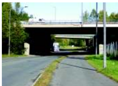
Dette er Osloporten fra øst, med sykkelstien til høyre. Benker skimtes i sentrum av bilde
