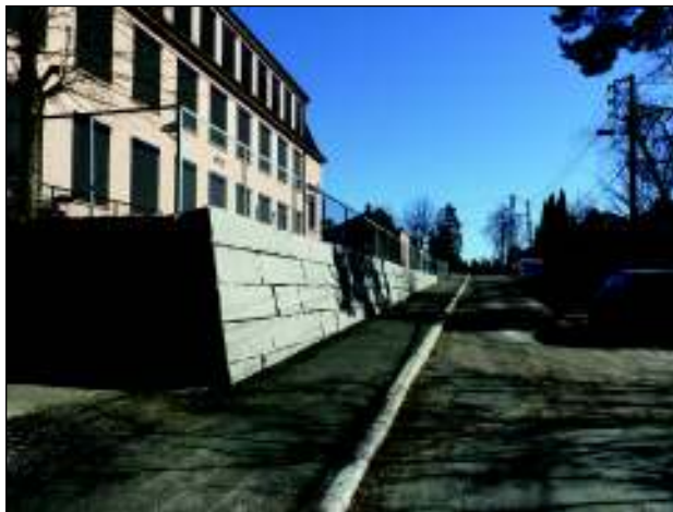
Ny mur på skoleveien og nytt fortau. Flott, endelig ferdig
