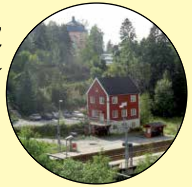
Høybråten Stasjon med Vel-Huset
