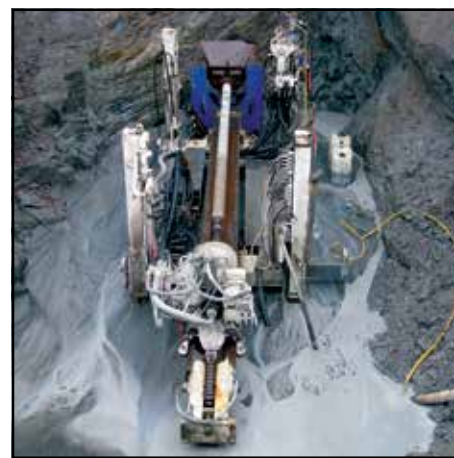
Kjerneboring var en forutsetning for tiltaket, og ble valgt for å unngå inngrep innenfor markagrensa.
