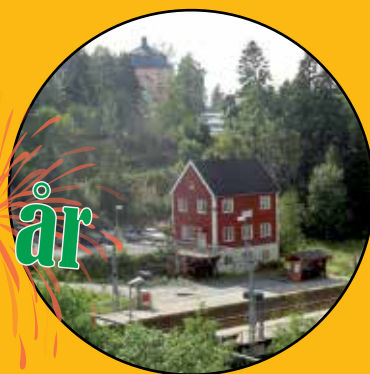
Høybråten Stasjon med Vel-Huset
