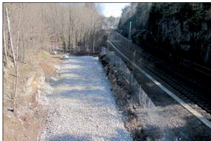
Ny gang- og sykkelvei fra Haugenstua til Høybråten.
