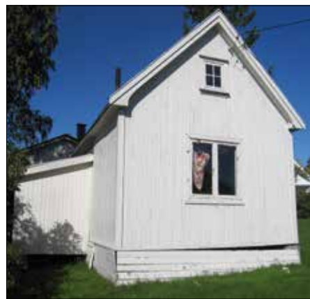
Bevaringsverdig hytte i Skanseveien 1c.
