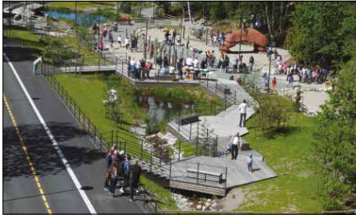
Bygger'n aktivitetspark sett fra jernbanebrua mellom Høybråten og Haugenstua stasjon. (Begge foto: Vel-Nytt.)
