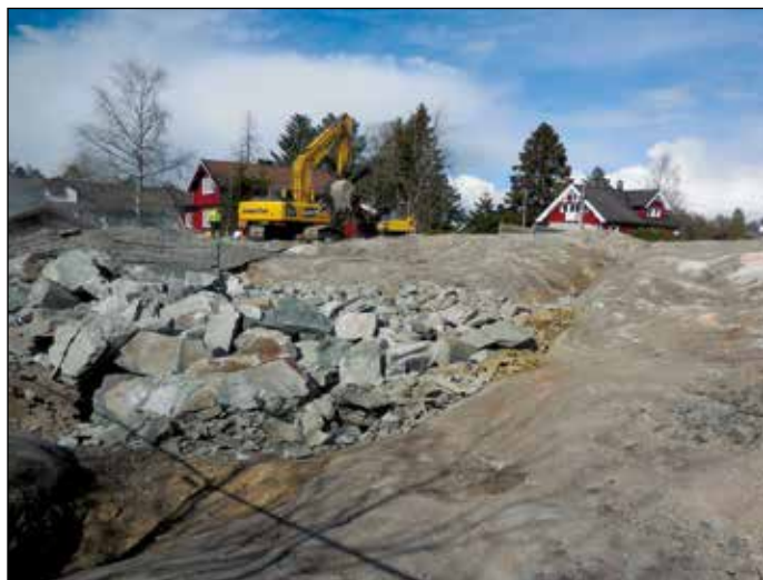
Folkvangveien 2. Oppriinnelig bolig er revet.
