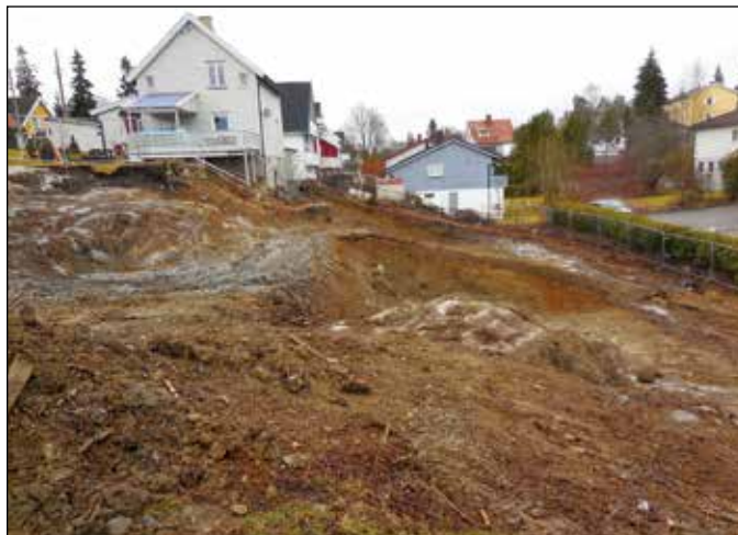
Myrbakkveien 1. Tomta er nå ryddet.
