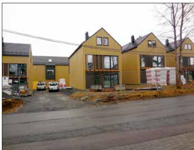
Høybråtenveien 52, sett fra Fredheimveien.
