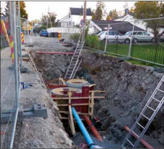
Det legges ny hovedvannledning med kummer i Vardeheimveien.
