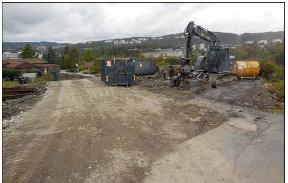
Oppryddingsarbeidet pågikk fortsatt da Vel-Nytt var bortom Stigenga i midten av september.
