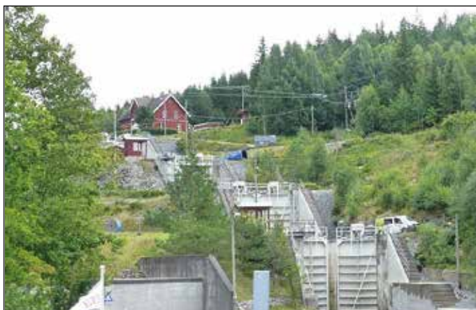
Brekke sluser i Haldenkanalen.
