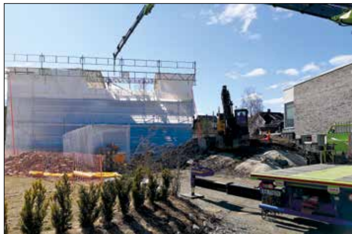
Brolandsveien 2 C, D.
