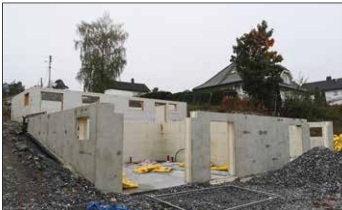
Høybråtenveien 64 A og C.
