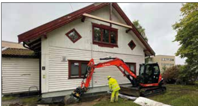
20. september igangsatte Oslobygg rehabiliteringen av Søndre Høybråten gård.
