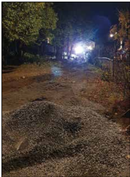
Fiberkablene kom på plass, det ble en lang arbeidskveld for gravemaskinkjørerene. Det ble gruset og feid og ryddet.
